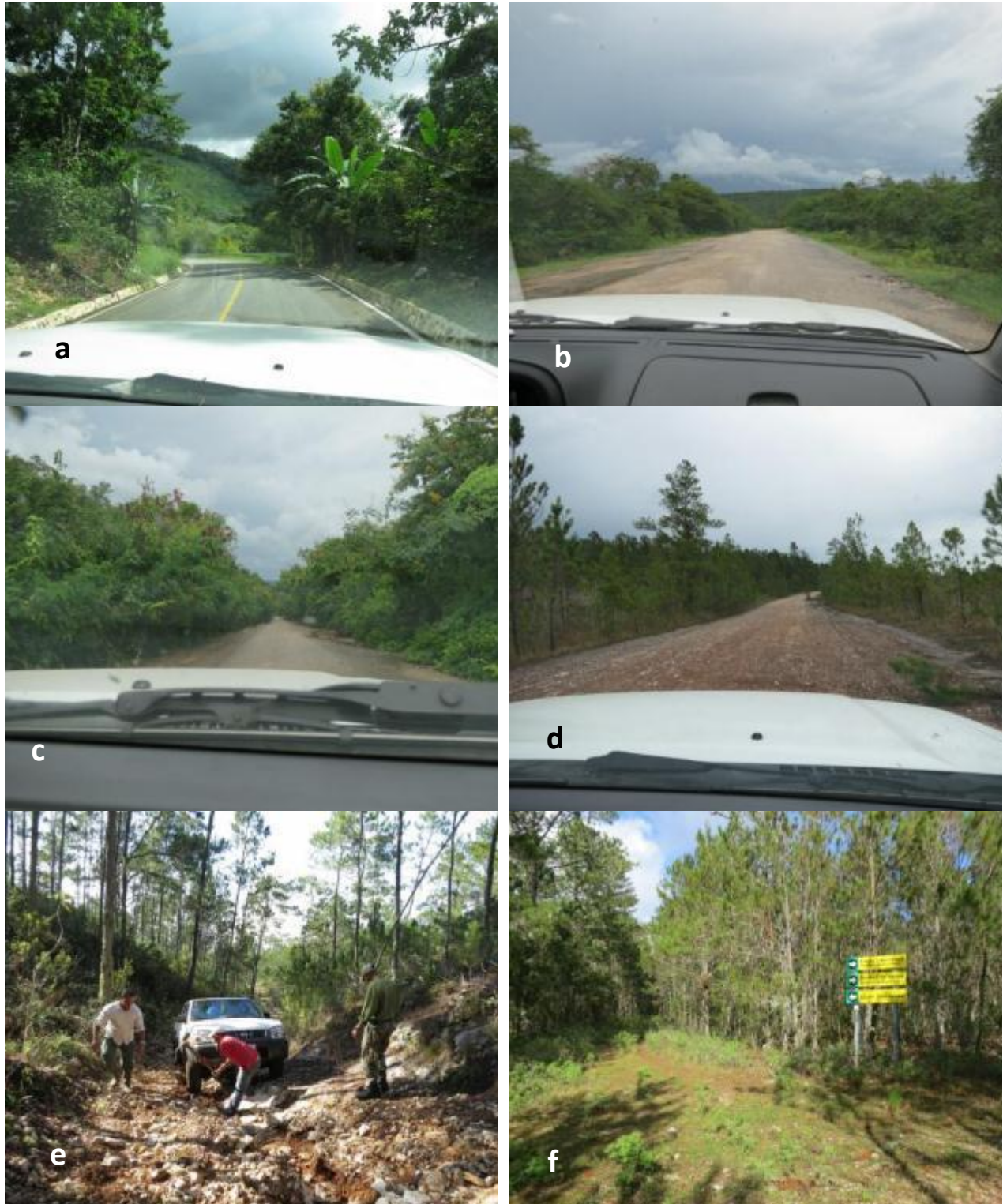
Figura 3. Vistas de los distintos tipos de vías en la zona de estudio: a-c = vía pavimentada hacia Aguas Negras y b, c =hacia El Aceitillar, d = superficie ligera transitable todo el año cerca de El Aceitillar, e = superficie ligera transitable en tiempo seco entre El Aceitillar y el cruce a Las Abejas, f = camino o rodera en la bifurcación del camino que viene de El Aceitillar hacia el oeste en el Parque Nac. Sierra de Bahoruco.
